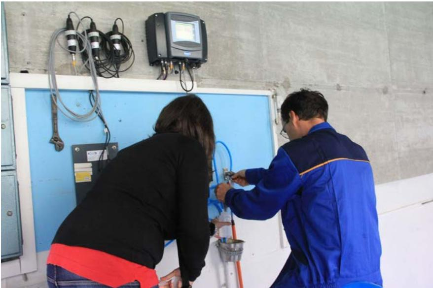
*Misurazione dei parametri fisici e campionamento dell'acqua per l'analisi chimica presso la stazione di pompaggio Mrzlek.*
